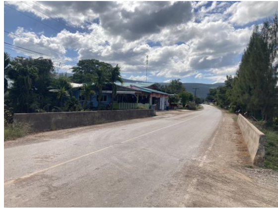
สร้างบ้านเรือนใกล้ทางน้ำและติดสะพาน
