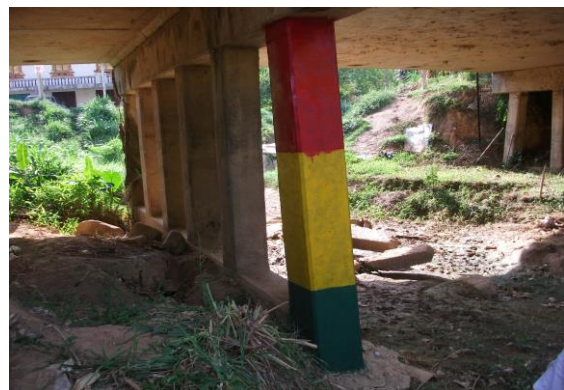
เสาวัดระดับน้ำ
