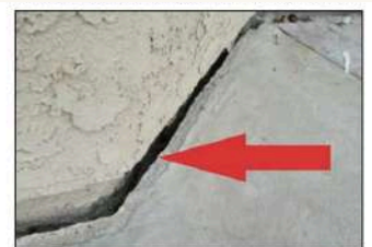
ดินเคลื่อนตัวออกจากฐานรากของอาคาร
