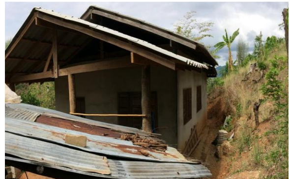
การสร้างบ้านเรือนใกล้ทางน้ำไหลผ่าน และตัดไหล่สร้างบ้าน บริเวณหมู่ 6 บ้านดงสังัด
