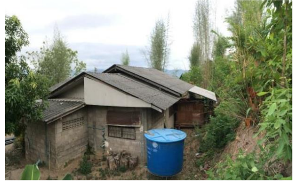
การสร้างบ้านเรือนใกล้ทางน้ำไหลผ่าน และตัดไหล่สร้างบ้าน บริเวณหมู่ 3 บ้านแพะ
