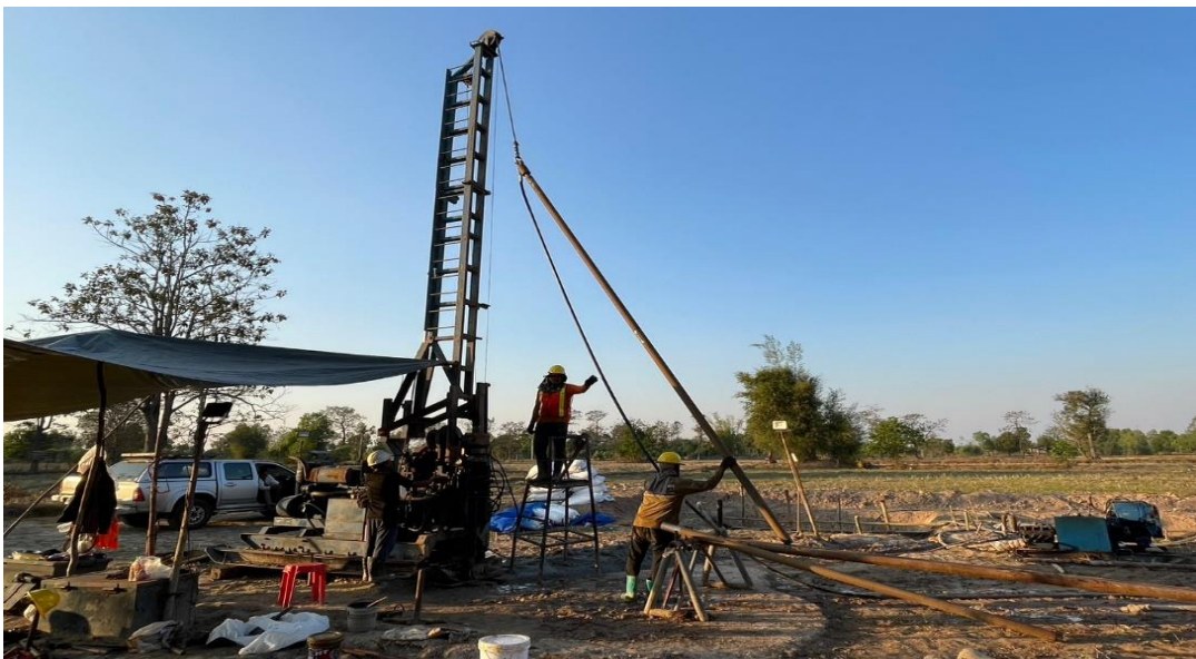
รูปที่ 5.1 การต่อก้านเจาะเพื่อเพิ่มระดับความลึกของหลุมเจาะ
