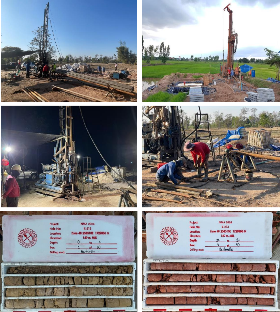
รูปที่ 3.13 การเจาะสำรวจแบบเก็บแท่งตัวอย่าง
